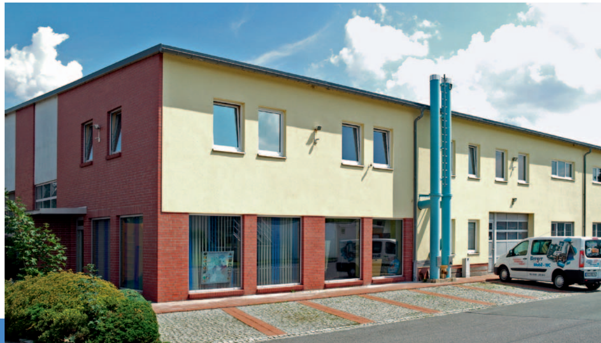
Seit 2008 in der neuen Produktionshalle in Ebendörfel
